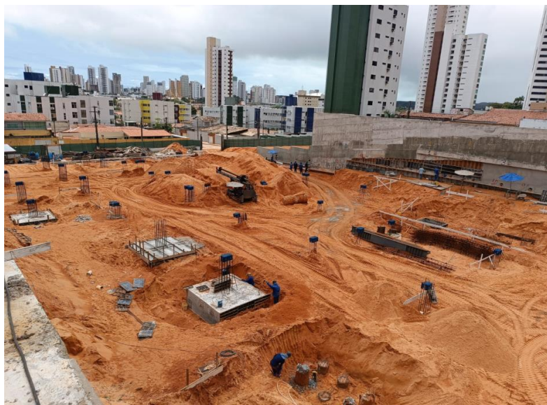
Figura 1. Visão geral da obra.
