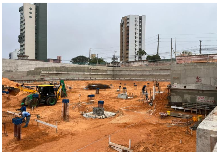
Figura 5. Furo para instalação do tirante e concretagem da viga tirante.
