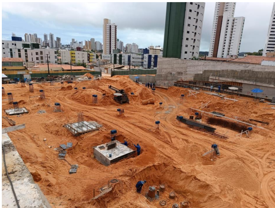
Figura 7. Blocos de coroamento e estacas de fundação.
