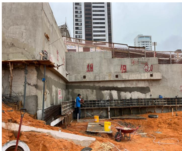
Figura 5. Furo para instalação do tirante e concretagem da viga tirante.
