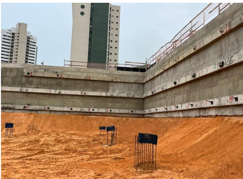
Figura 4. Tirantes da terceira linha sendo executados.
