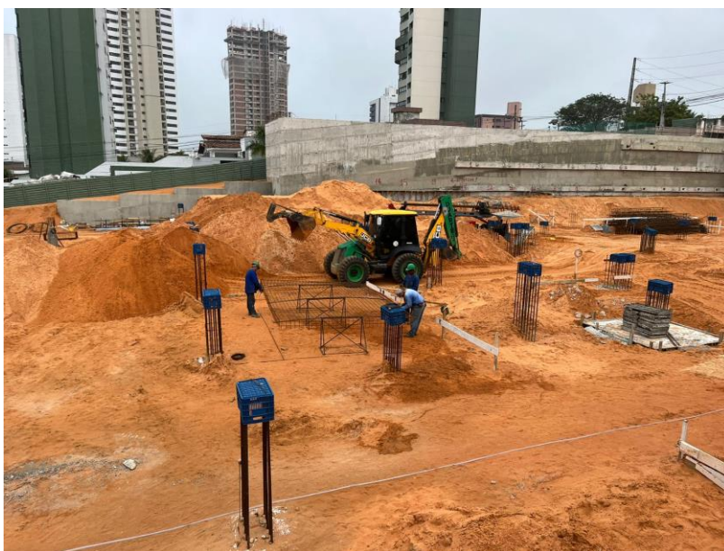
Figura 2. Movimentação de terra e quarta berma restante.
